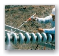
infrastructures qui dépendent de l'électricité. Les cendres mouillées sont conductrices, il est donc essentiel que les procédures de fonctionnement sans danger soient strictement suivies lors du nettoyage des équipement d'alimentation en électricité.
